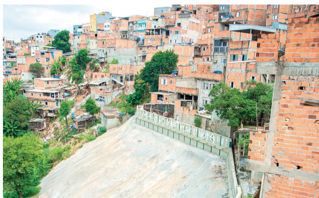
A obra contou com a construção de contenção, drenagem de águas fluviais e recomposição de asfalto
